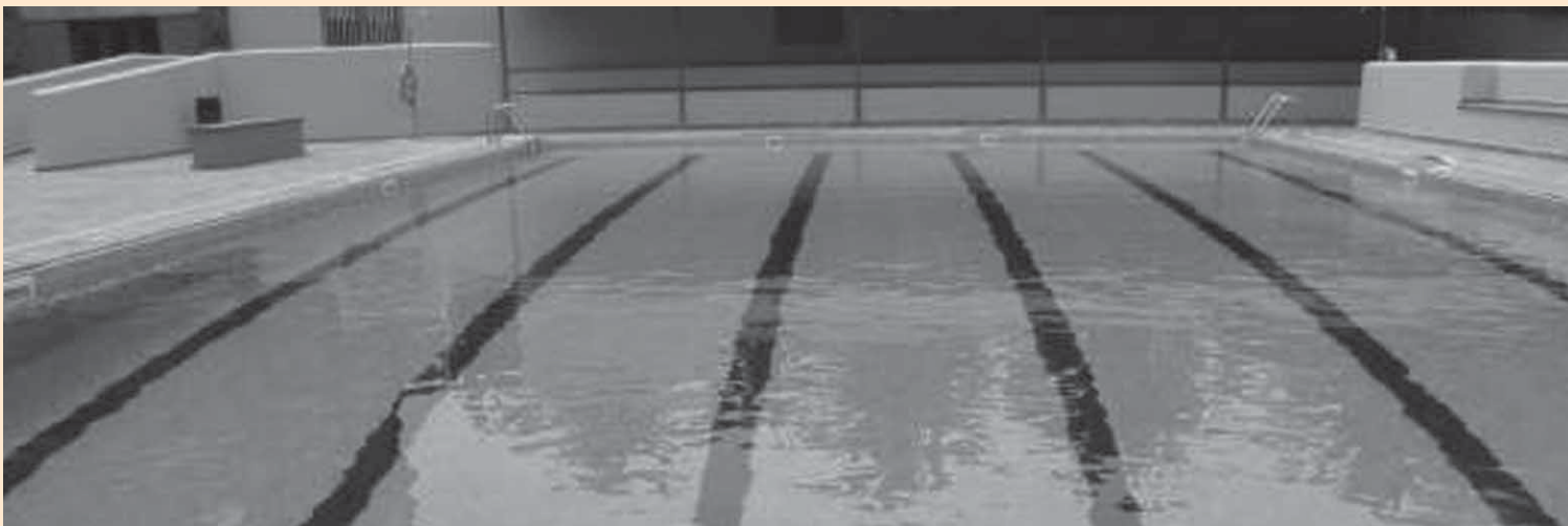
Reformas Piscina Municipal de Pájara
